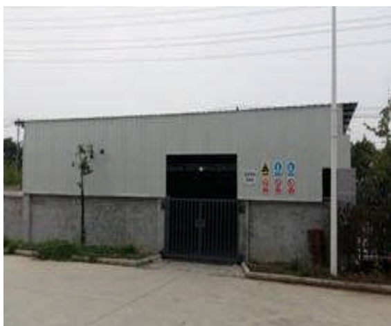
危险废物暂存间
