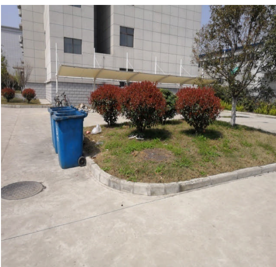
生活污水标准化粪池
