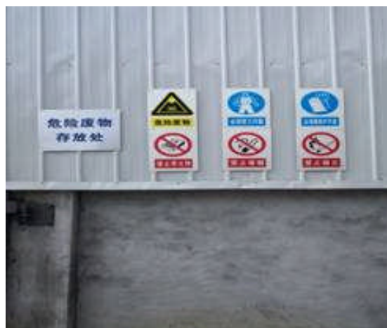
危险废物暂存间标识标志
